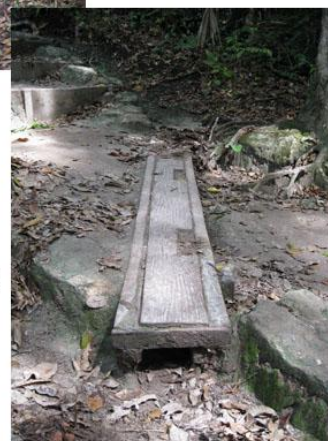
Espigones de madera utilizados para encauzar las correntadas y evitar la erosión, en Tikal
