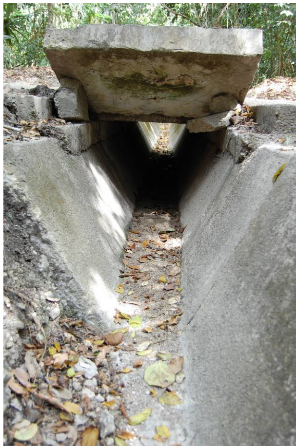
Lamina 1-2. Drenaje actual. L. Grazioso
