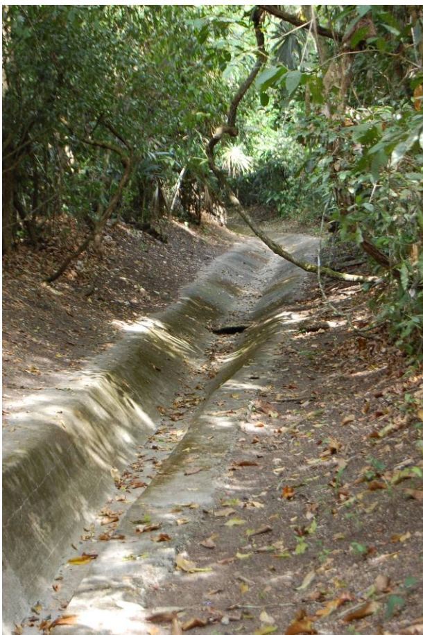
Lamina 1-1. Drenaje actual. L. Grazioso
